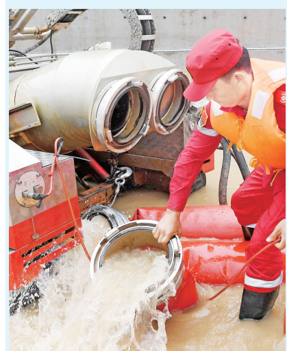
7月22日,来自江西的救援人员在郑州市京广南路隧道进行排水作业。(新华社记者 李安 摄)
