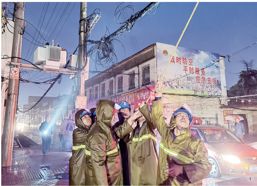
图① 7月20日晚,内黄县10千伏内8#老城线干线东大街支线因强降雨造成断线故障。内黄县供电公司30余名抢修队员第一时间赶赴现场,紧急疏散周围群众,拉起警戒线,连续冒雨抢修3个多小时,为广大群众及时恢复了供电。(韩洋 摄)
