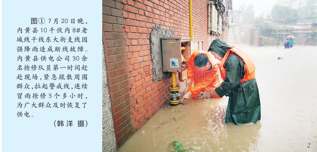
图② 安阳华润燃气工作人员正在关闭燃气调压箱阀门。(代艳敏 摄)
