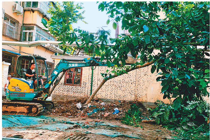
老旧小区改造现场(资料图)
