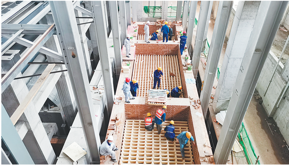
项目建设现场
