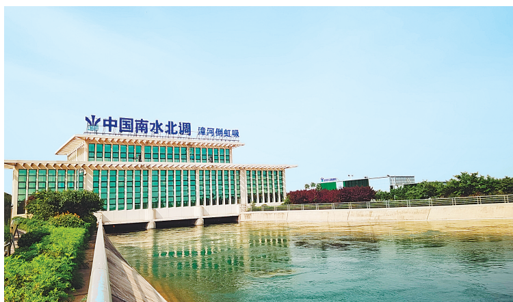
南水北调中线总干渠安阳段穿漳工程一景
