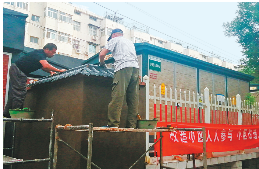
施工人员正在为墙头盖瓦做轮廓
