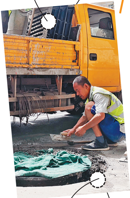
工人们安放好的新窨井盖用水泥进行加固
