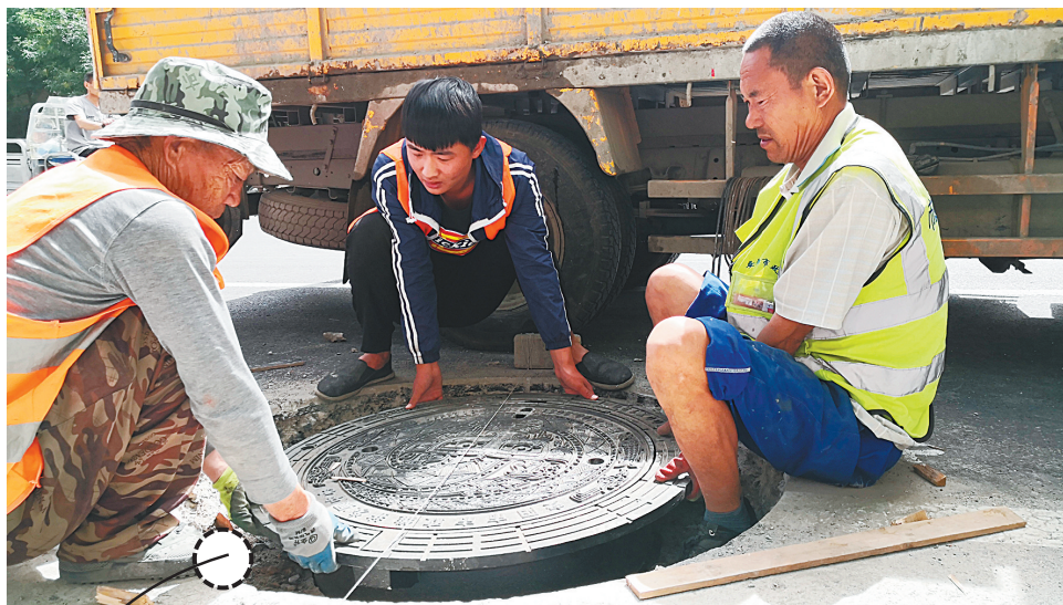
工人们把新窨井盖放到窨井上,保证水平
