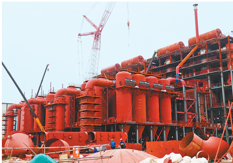
内黄县陶瓷园区清洁工业燃气集中制气项目建设现场
