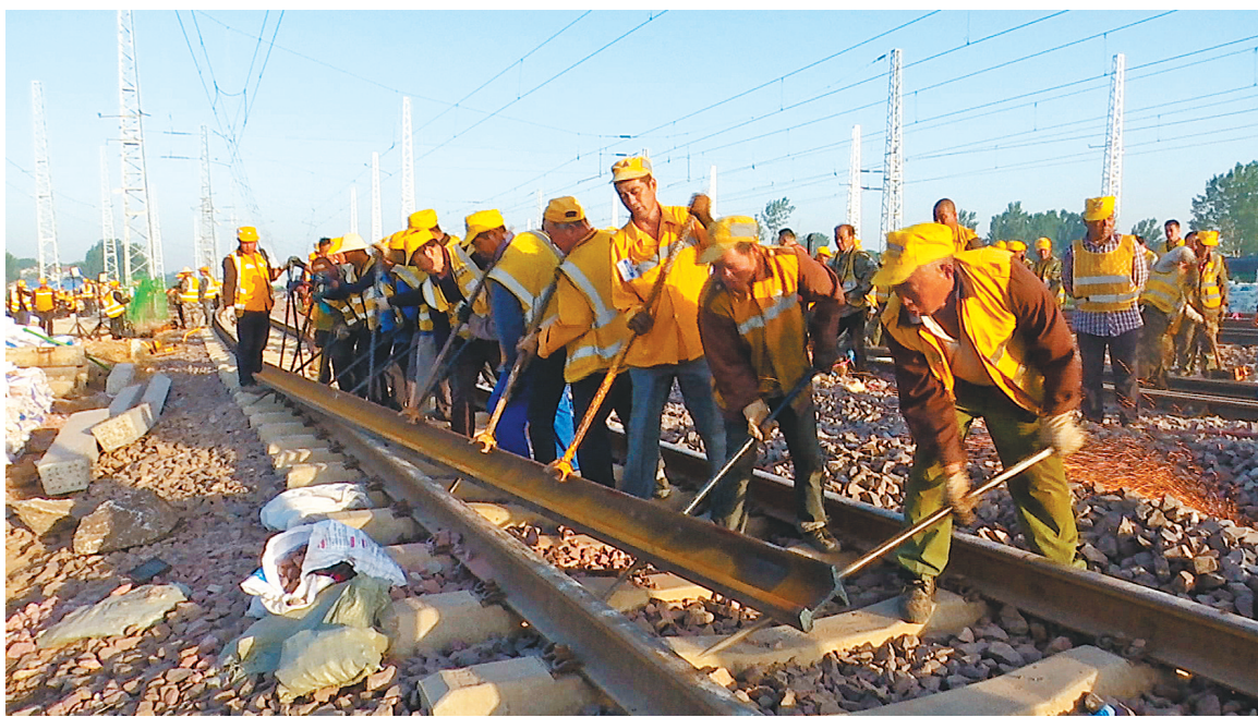
滑县专用铁路项目牛屯南站施工现场(王中瑞摄)
