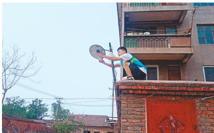
濮化社区工作人员更换2号居民楼前的路灯(焦欢欢 摄)
