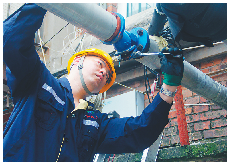
黄志刚正在冲洗管网(张承摄)
