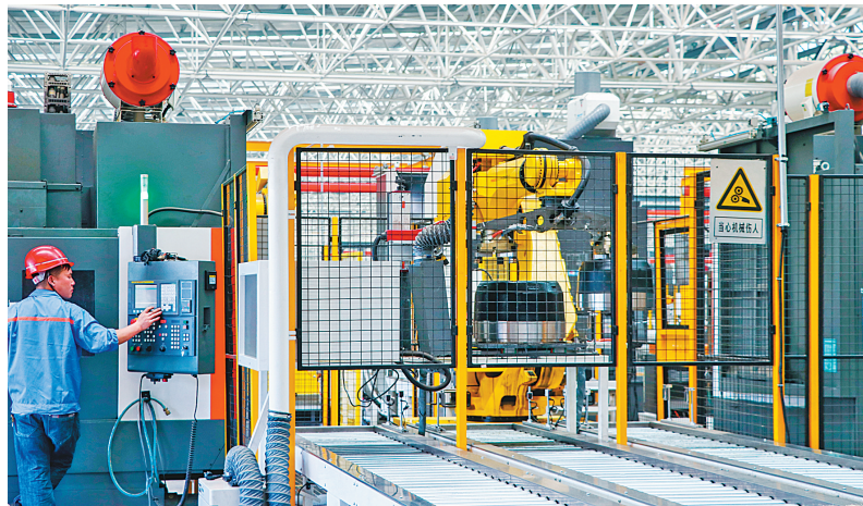
凤宝重科钢管整体成型车桥零部件项目智能化生产线(陈煜航 摄)
