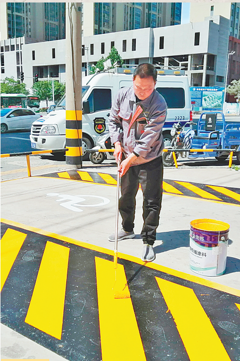
▲工作人员正在现场施画无障碍停车位 (本报记者 高咪 摄)
