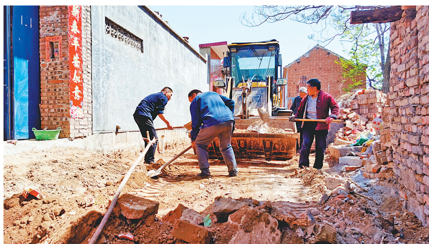
柳泉村硬化道路施工现场(李贤 摄)
