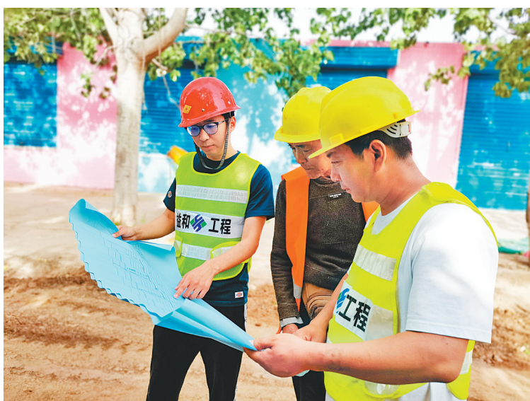
李晨龙(左一)正在对施工人员进行讲解施工要点(张承 摄)
