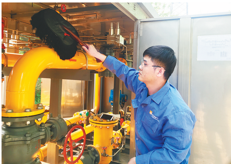
张小虎正在检查管线
