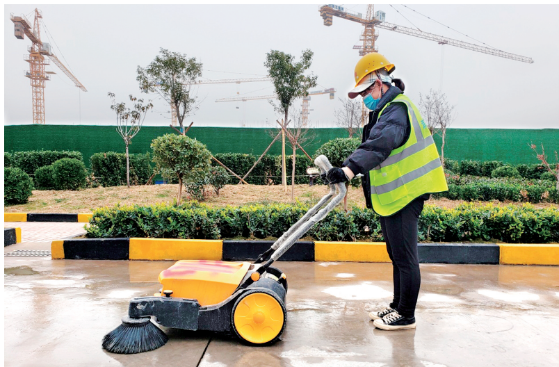
建筑工地工作人员保持地面干净整洁
