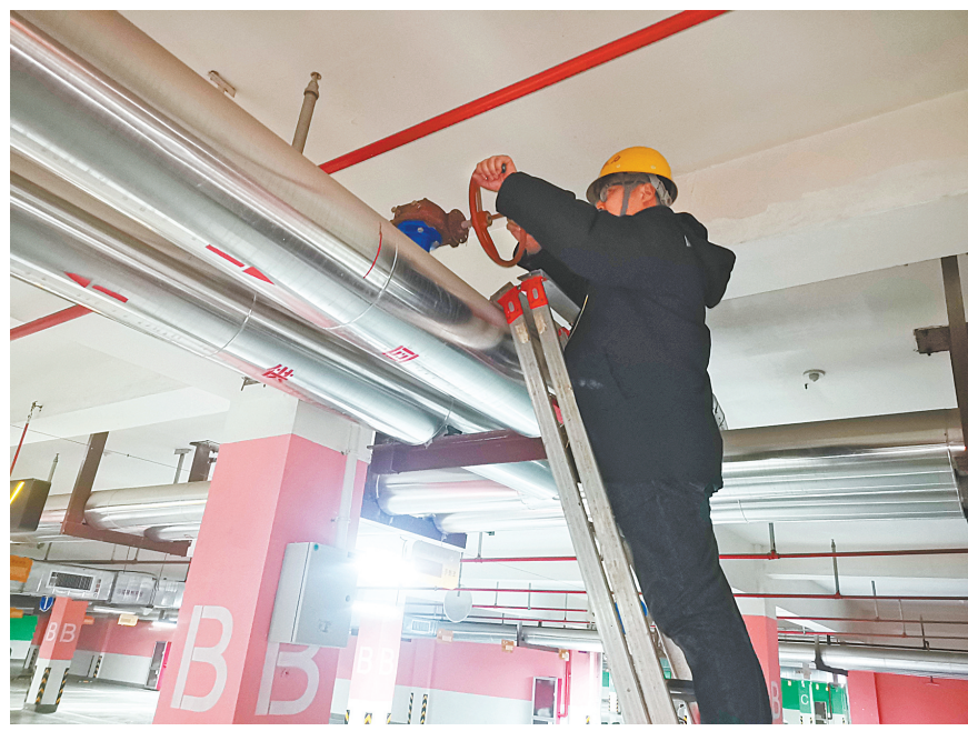
工作人员正在平衡管网(张承 摄)
