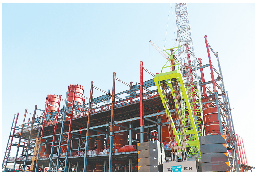
陶瓷园区清洁工业燃气集中制气项目建设现场
