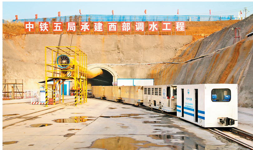
南水北调安阳市西部调水工程林州段隧道掘进施工现场(本报记者 郭荣 摄)
