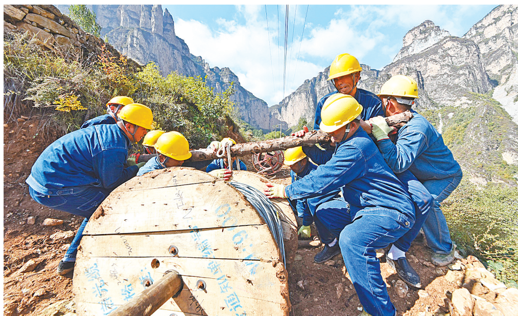
国网林州市供电公司组织施工人员在林州市石板岩镇椿树坪村实施农村电网改造升级工程(苏世一摄)
