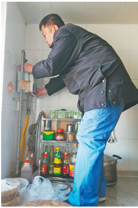
赵亮正在检查燃气漏气情况
