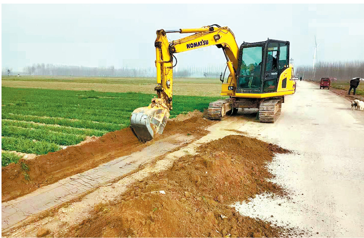
12月15日,在中鹤线梁庄镇段建设现场,挖掘机正在作业。
