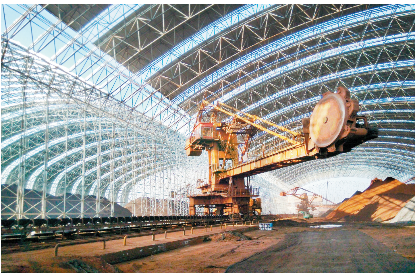
安钢集团运输部第二原料车间深入推进清洁生产工作,通过建造原料大棚、采用高压细水雾抑尘、出入口安全全封闭洗车台、美化绿化外部环境等举措实现了料场存储的清洁生产。图为12月11日,该车间堆取料机取料现场。(郭芳摄)
