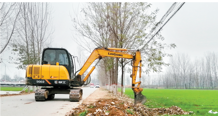
正在建设中的“四好农村路”
