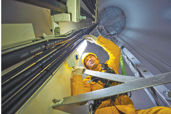
工作人员定期检查风力发电机组内部输电电缆
