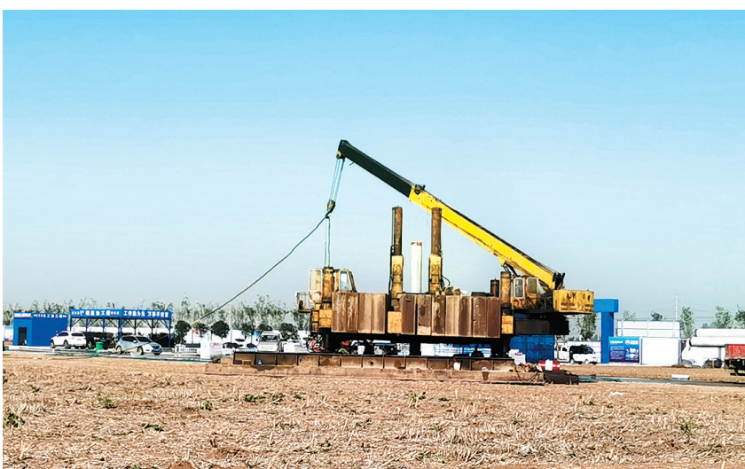
正在施工中的河南旭阳光电科技有限公司
