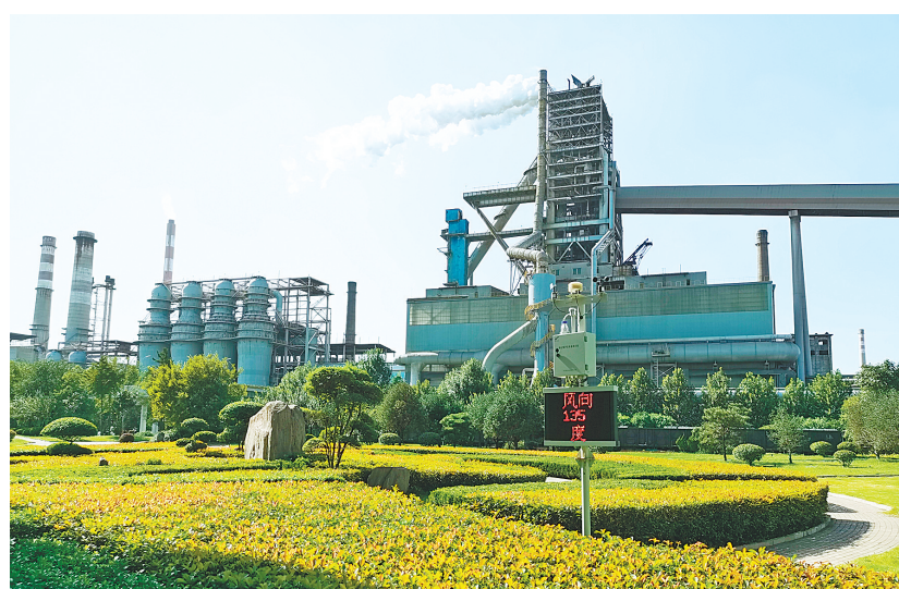
安钢集团4747立方米特大型高炉生产时的情景
