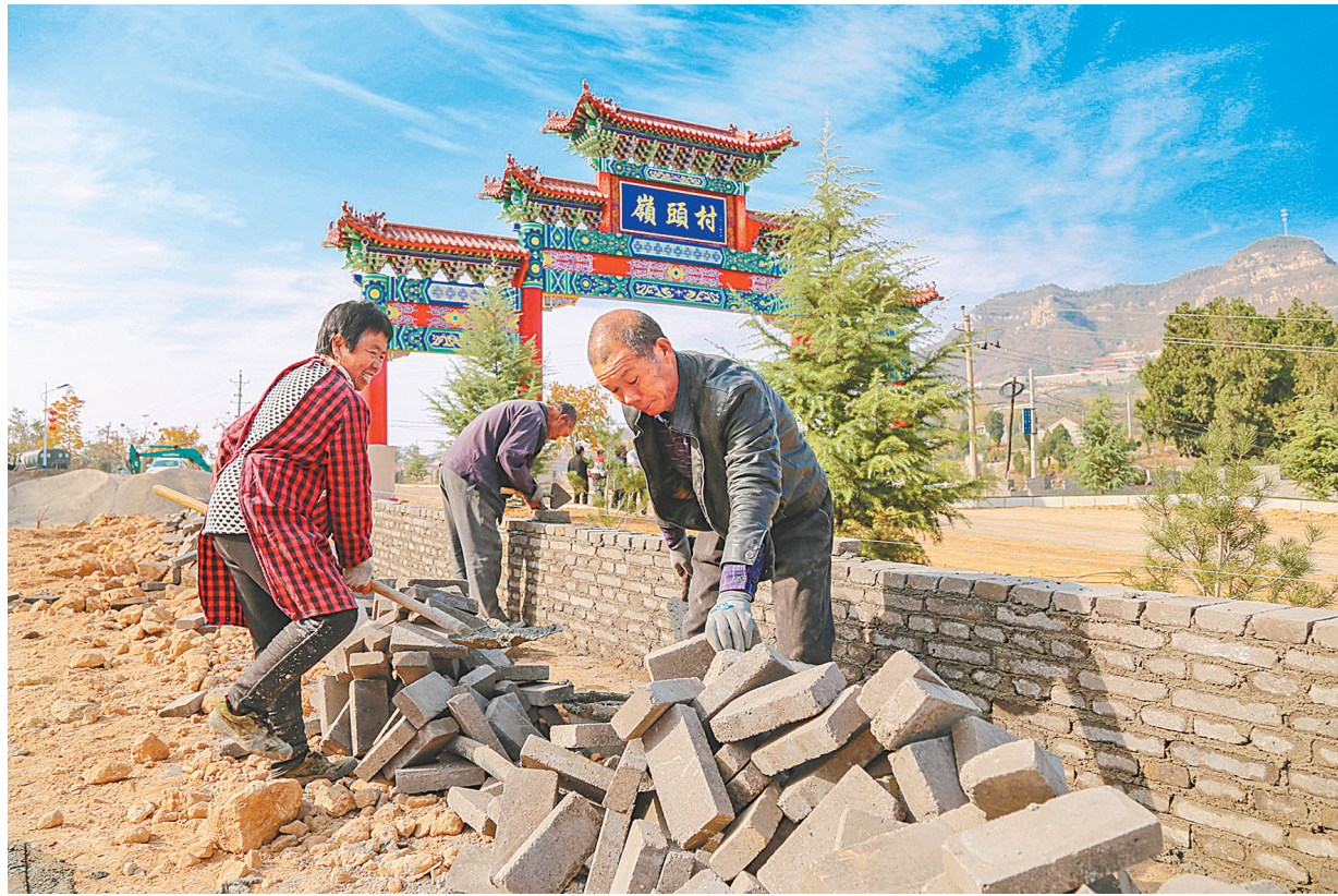
村民正在为新修的道路砌护墙
