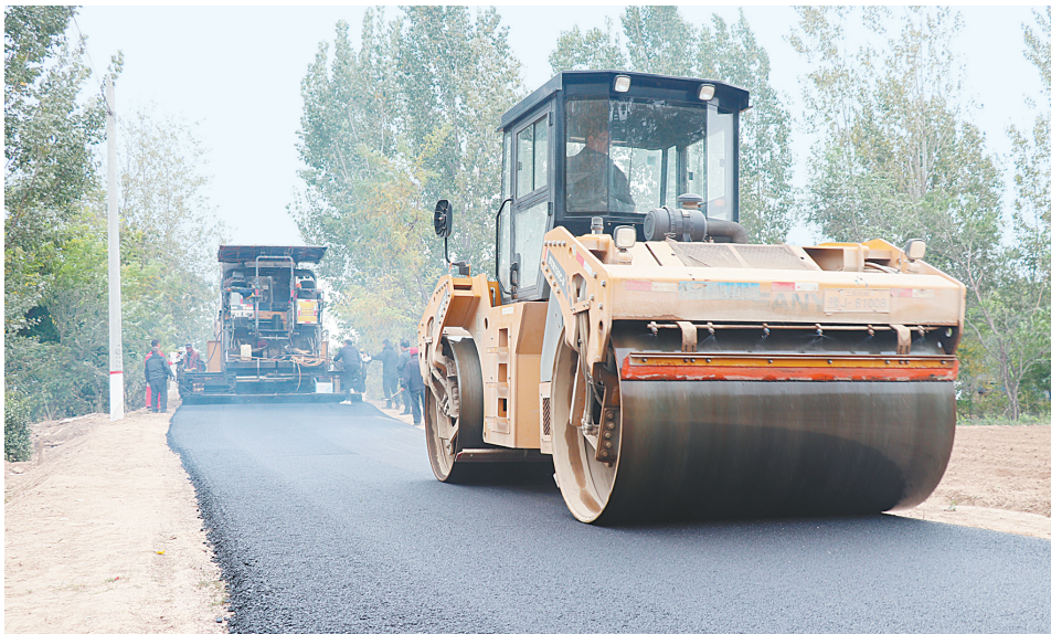
乡间道路沥青混凝土铺设现场
