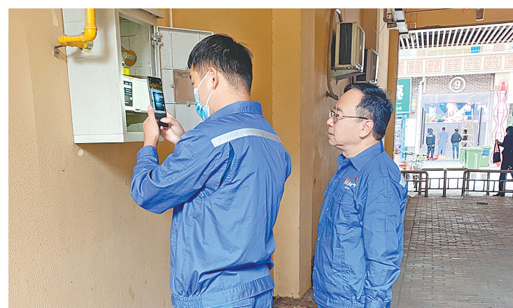
工作人员正在进行安全排查(秦莹 摄)
