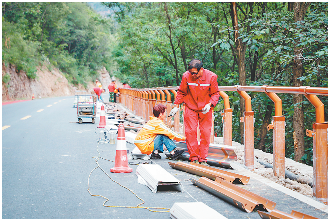
工人正在石阱公路上施工
