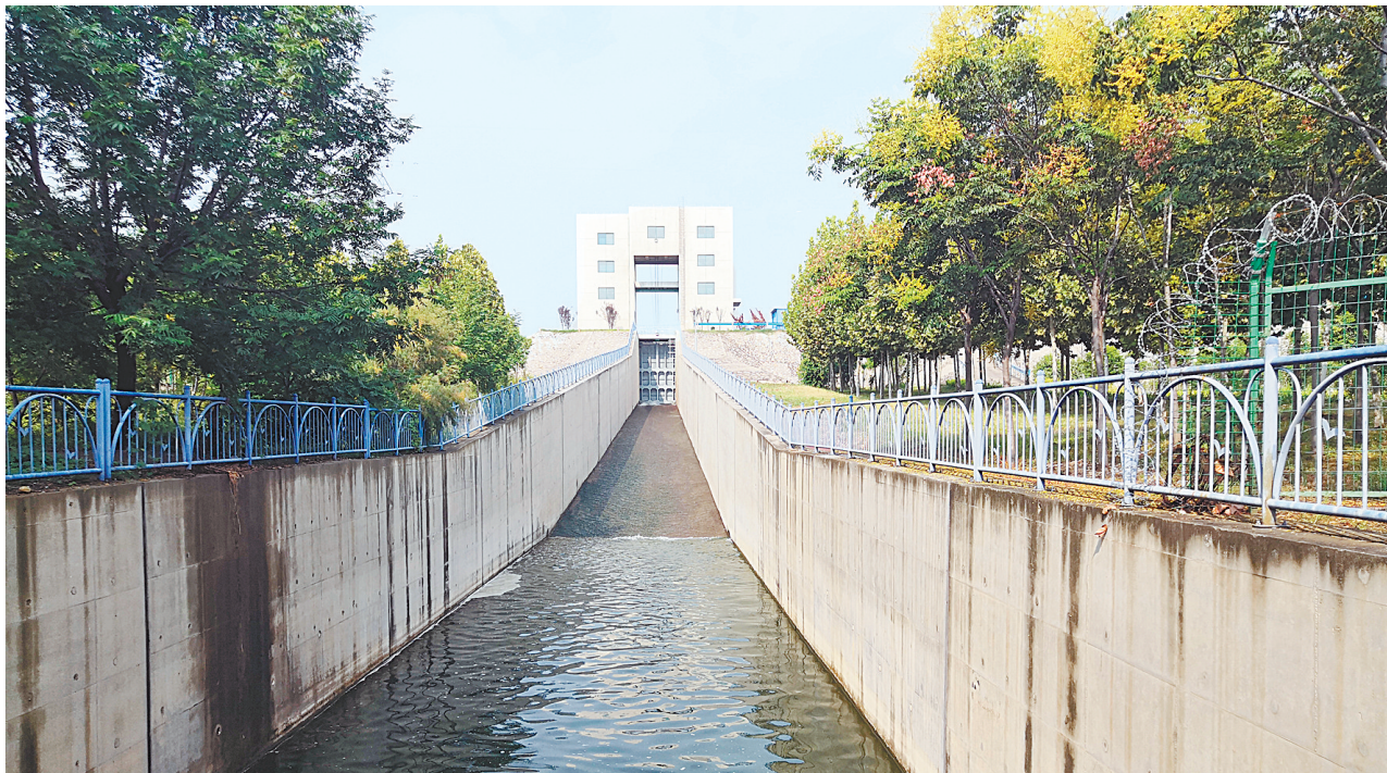
南水北调中线工程汤阴段退水闸
