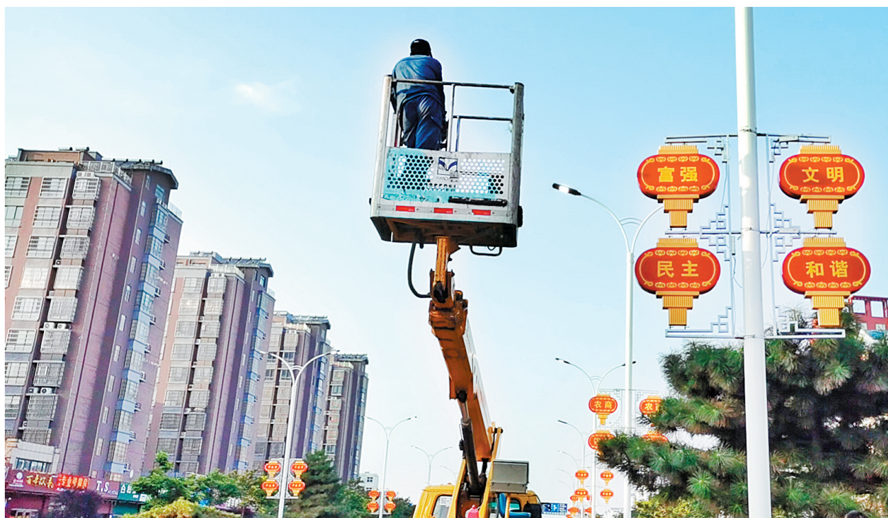
滑县住建局路灯所员工正在对路长反馈的问题路灯进行维修(程广如 摄)
