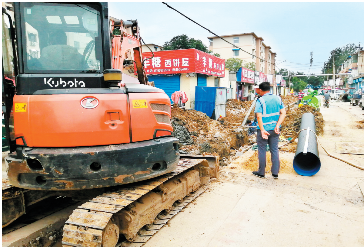
浉北小区改造现场
