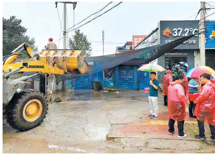
弱电入地施工现场
