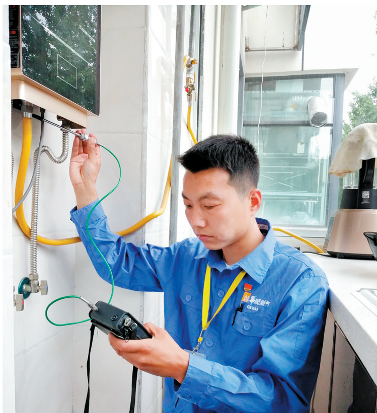
梁伟正在对燃气管道进行检查
