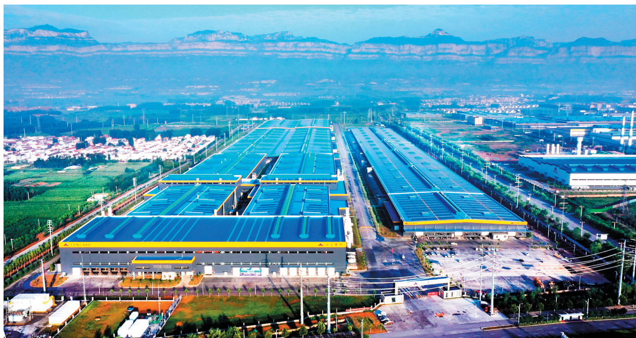
投入运行的粤电林州凤宝重科34兆瓦屋面光伏发电项目(冯元庆 摄)
