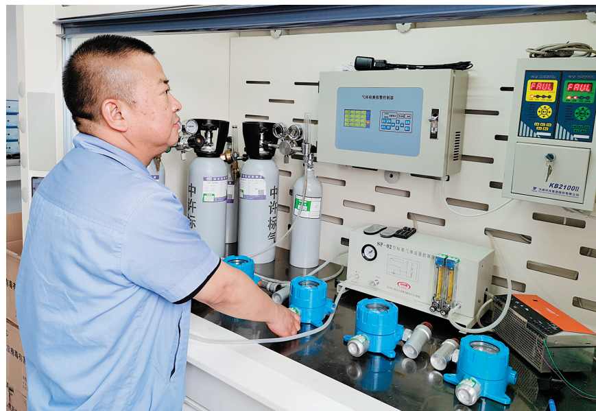
项目负责人贾晓彬在调试门禁智能管控系统(本报记者 姚芳 摄)
