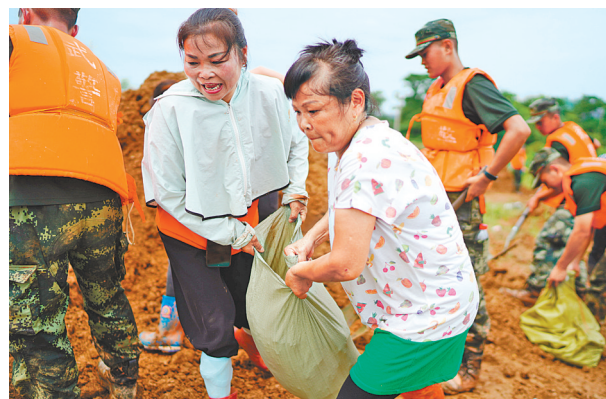
7月11日,在江西省鄱阳县鄱阳镇江家岭村,“阿姨团”成员江云凤(前)和余凤英在圩堤施工现场挪动沙袋(新华社记者 周密 摄)
