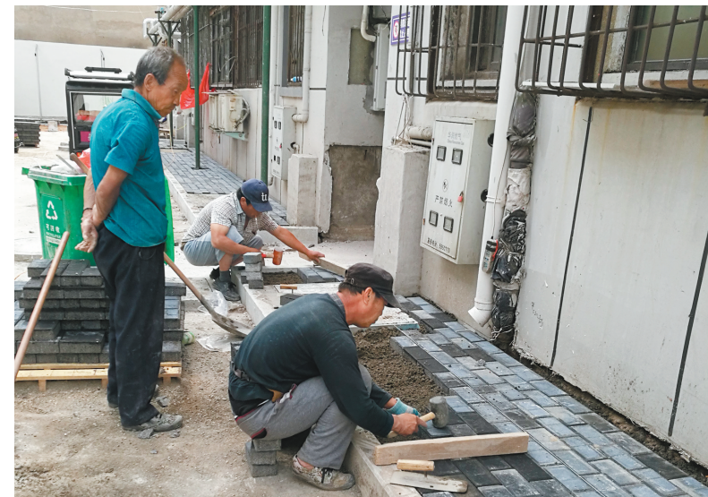
工人在民航路24号院内施工修繕
