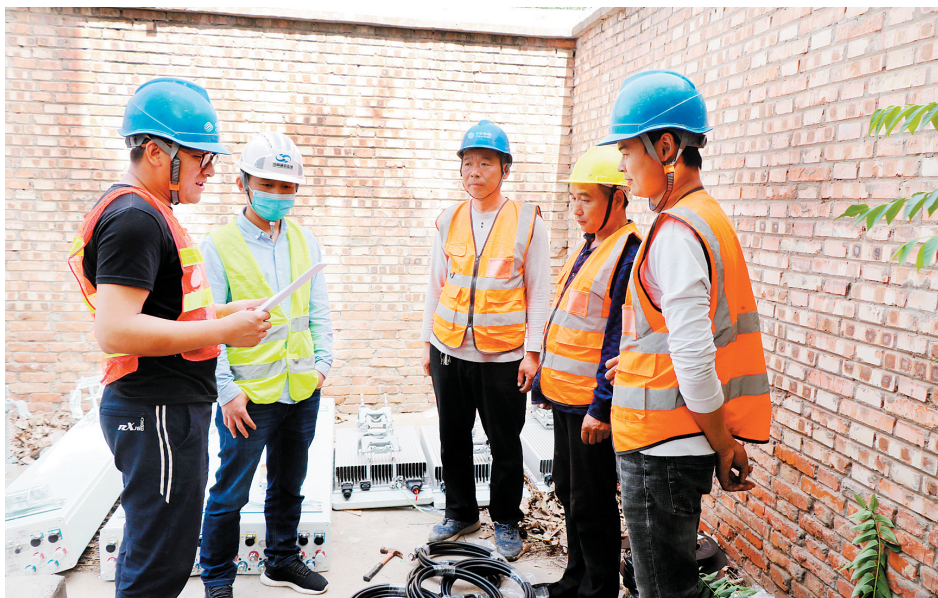
工程监理徐明超(左一)带领施工队在滑县小铺乡大铺村(大铺东基站)建设5G基站
