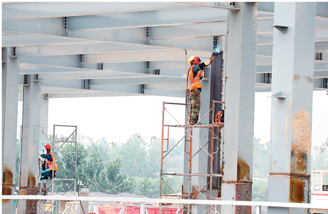
项目建设现场
