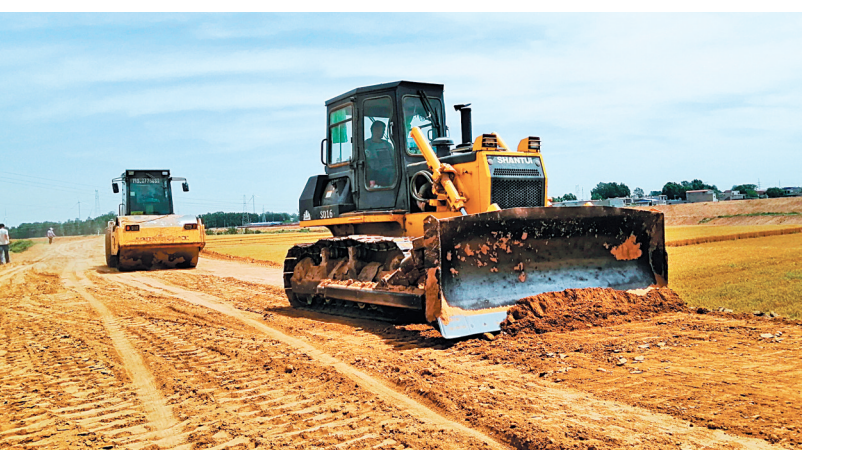
洹河韩化至张奇段河堤施工现场
