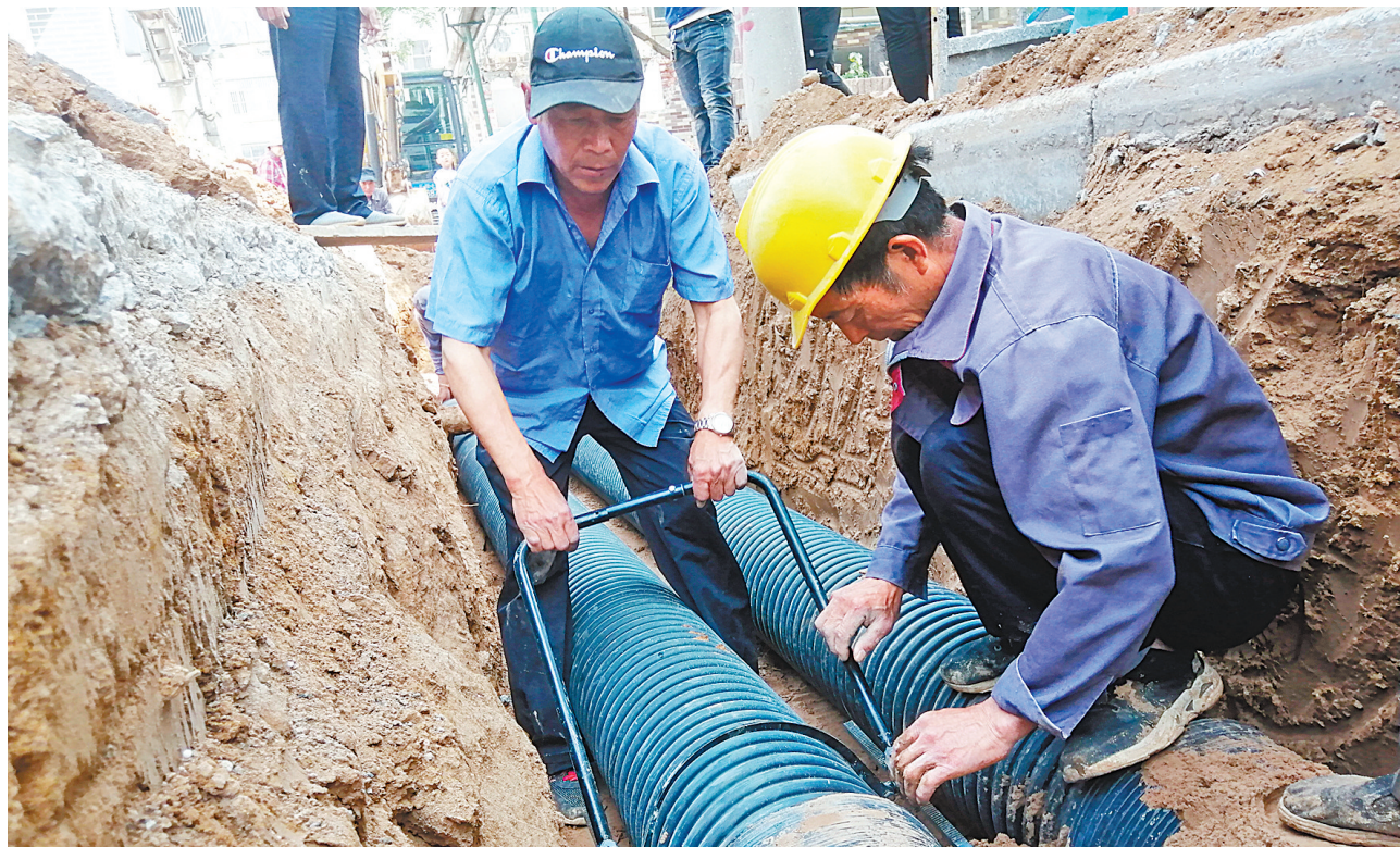
文明小区老旧小区改造现场,工人正在对接管道
