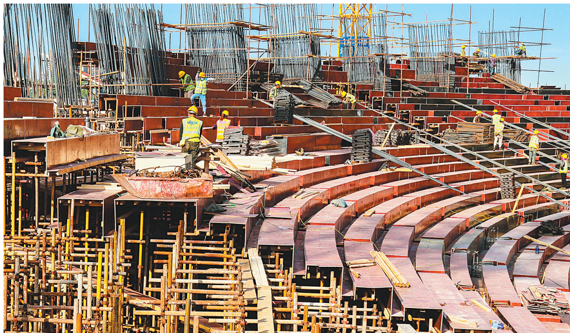
体育场看台施工
