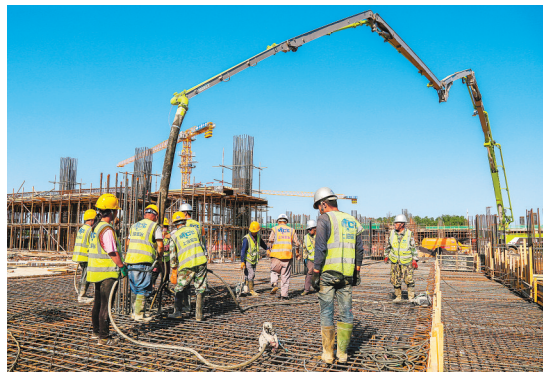
浇筑混凝土
