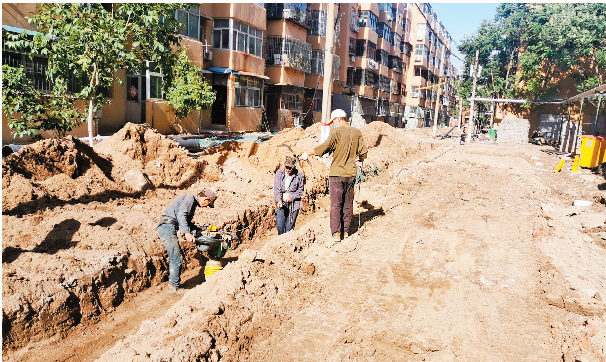
老旧小区改造升级施工现场
