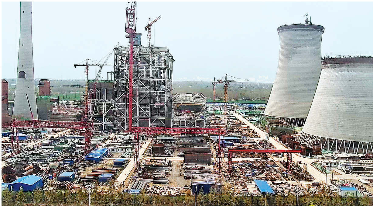
滑县热电联产项目施工现场(资料图)
