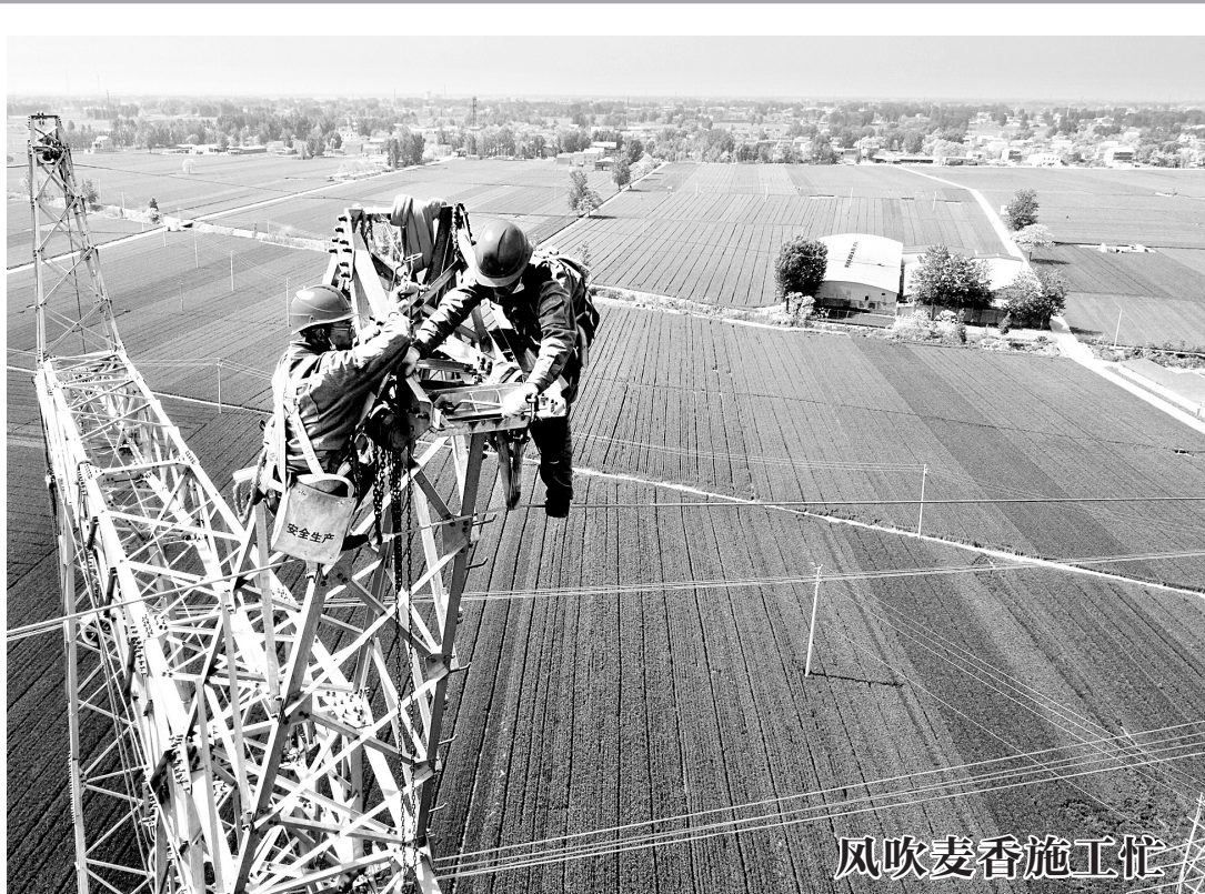
5月5日,滑县广粟的田野上处处麦穗丰盈,孕育着丰收希望。该县上官镇蓝旗屯村国家重点工程500千伏塔线滑县段建设进入尾声,电力工人正在紧张作业,确保滑县区域正常供电。(文摄 摄)
