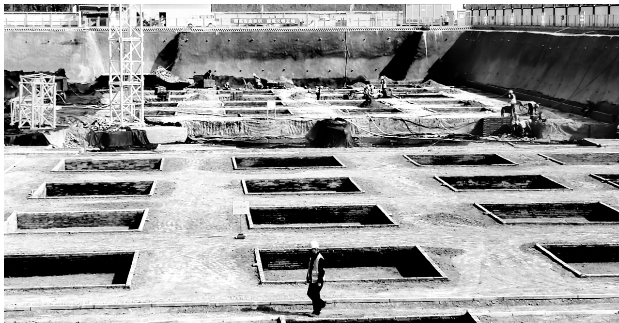
龙安区两河新城大棚改造项目施工现场
