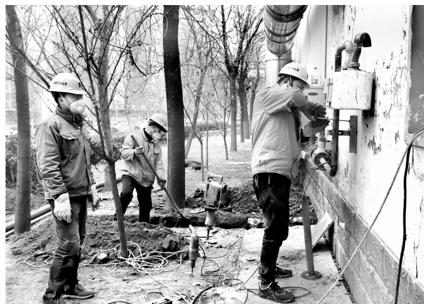
安阳华润燃气施工人员正在安装调压箱和电表(张璐璐 摄)
