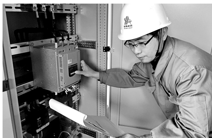
李磊正在进行PLC柜上电检测
