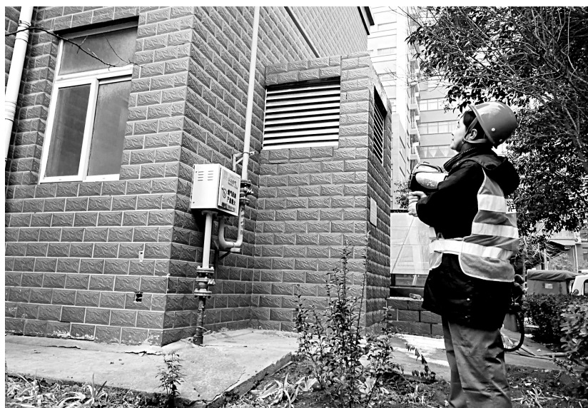
付红英正在小区进行燃气检测
